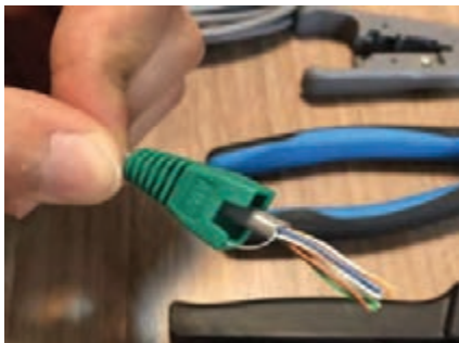
شکل ۲۶- وارد کردن کاور سوکت سر کابل
