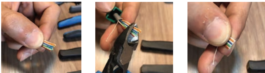
شکل ۲۷- مرتب کردن سیم‌های رنگی مطابق استاندارد
