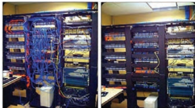
شکل ۴۱- مرتب کردن کابل‌ها
