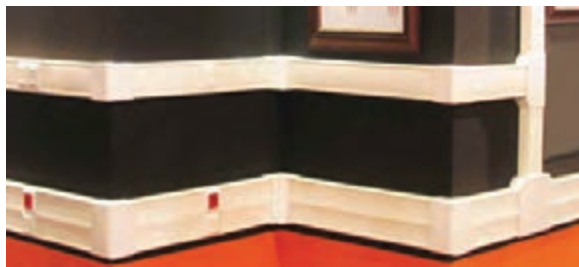
شکل ۵۳ - محل تقاطع ترانک‌ها و داکت‌ها
